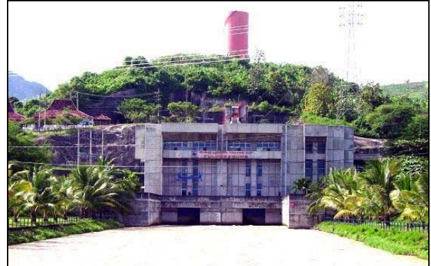
トゥルンガゲン発電所（インド洋海岸）、ネヤマ 排水利用 P=36,000 kW、1991 年完成
