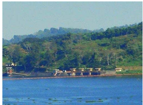
カリコントダム、H=49mはオランダ時代に建設された調整池を持った2万9千kWの発電用水に利用された、1972年完成、目的：灌漑、発電、洪水調節、写真はダムの取水ゲート
