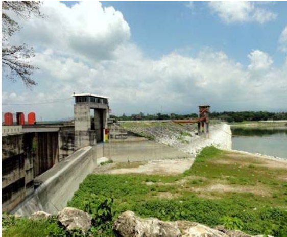
カラんかテスダム (H=100m) の取水口と余水吐
