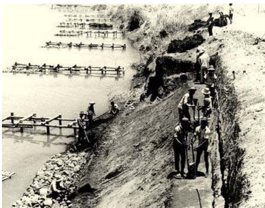
ポロン川改修工事、護岸工事と水制工事
