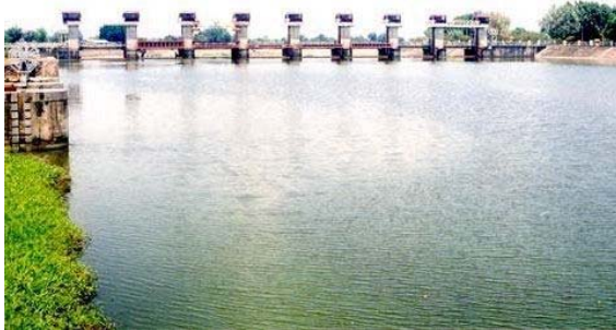
レンコンダム、ローラーゲート幅 11.1m x 高 4.8m x 門数 8、目的：スラバヤ川とポロン川へ の洪水流量調整、灌漑用水・都市用水の分流
