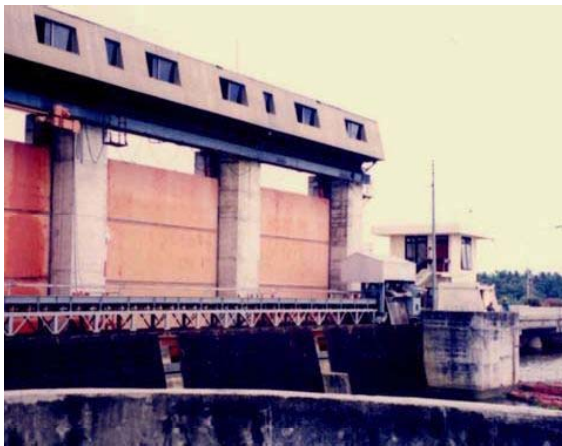
ウリングダムの取水ゲート
