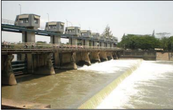
ロドヨ調節堰（ウリングダムのアフターベイ）、 ローラーゲート幅 12.0m x 高 11.3m x 門数 8、 1983 年完成、目的：流量調節、ピーク発電 4,500 kW
