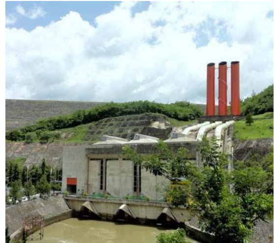
カラんかテス発電所とイ国の特産品「竹」を模したサージタンクとペンストック、1973年完成、目的：灌漑、発電、洪水調節、都市用水
