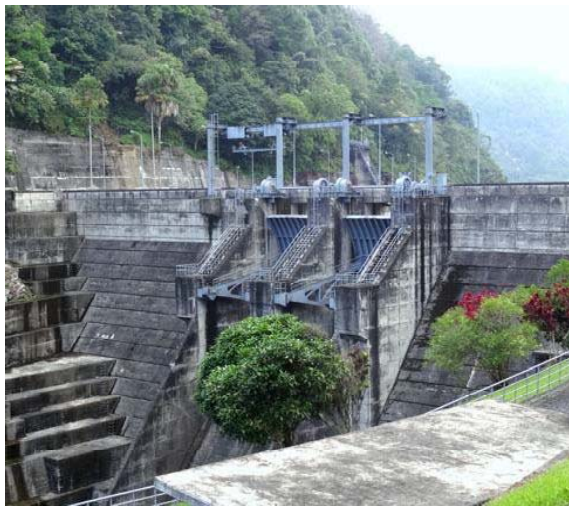
上流から二番目のシグラグラダム H=48.5m
