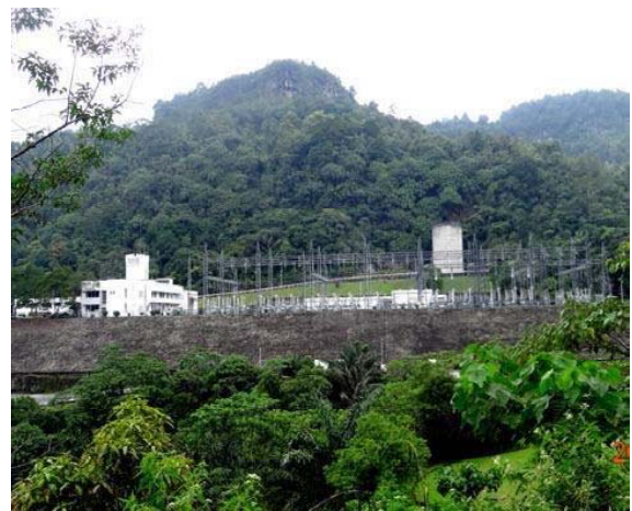
シグラグラ地下発電所 (P=60.3MW) の地上の 変電所、1981年完成
