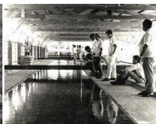
河道改修のための移動床水理模型実験中の筆者（ブランタス事務所）
