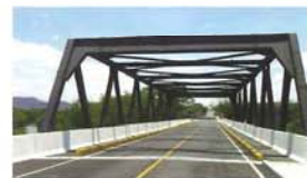
ラス・バンデラス橋 (ニカラガ) 海外橋梁
