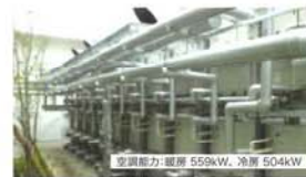
数月増築工場棟 地中熱空調システム (東京都) 地中熱ヒートポンプ空調システム 空調能力: 暖房 55kW, 冷房 50kW
