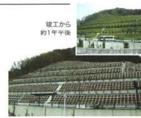
奥山地区改良工事 (長崎県) 法面防災緑化工法 竣工から 約1年半後
