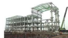
海外鉄骨製作工事 (ベトナム) エンジニアリング業務
