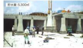
常永4号貯水槽 (山梨県) プレキャストPC製地下貯水槽 貯水量: 5,300㎡
