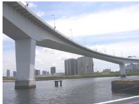
有明西運河橋
