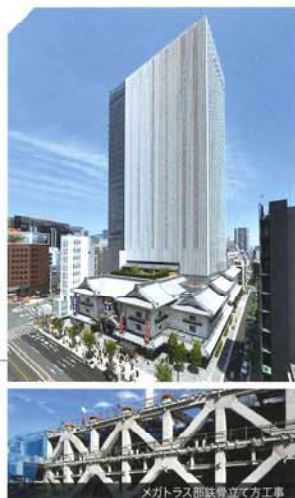
メガトラス部鉄骨立て方工事
