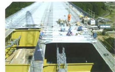
SCデッキ®(合成床版)による床版工事
