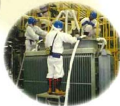
■防護服着用による処理作業
