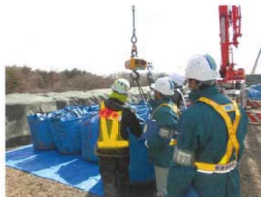
【仮置場からの積み出し工事の様子】
