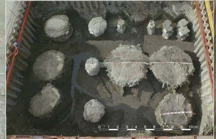
改良体出来形確認試験の状況
