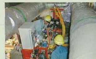
施設の配管の間から施工
