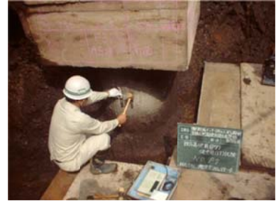
基礎下における既存杭の健全度調査
