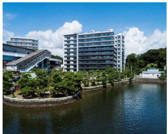
横浜市金沢区瀬戸2丁目計画新築工事
