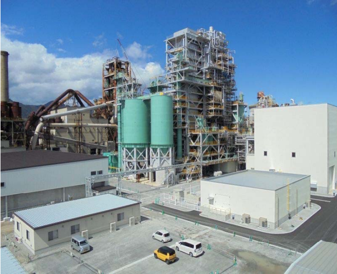
佐伯地区バイオマス発電設備建設工事
