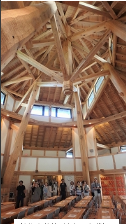
越後森林館（木組み架構）
