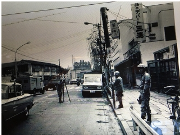
新宿シールド工事での測量の様子（右端が筆者）
