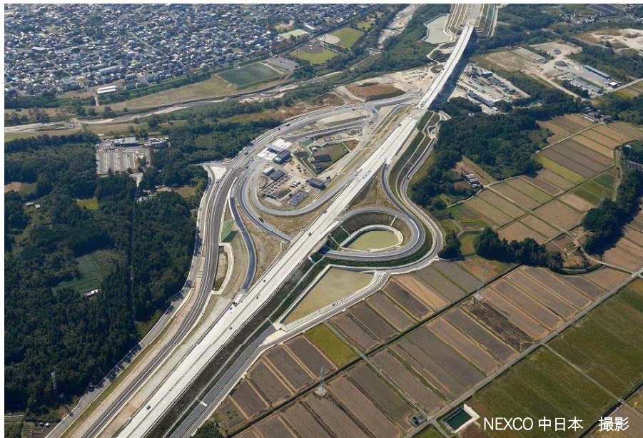
菰野インターチェンジ全景 (H31.3.2 撮影)
