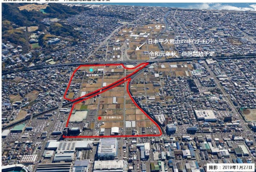
事業区域全景（北から南（駿河湾）を望む）
