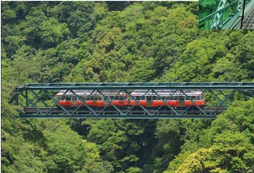
箱根登山鉄道早川橋梁:1888年(明治21年)に英国で製造された天竜川橋梁の一部を現在の場所に移設した日本最古の鉄道橋です。私たちは今でも定期的な点検・補修を行いながら日本最古の鉄道橋を見守っています。
