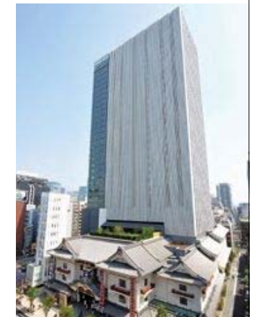
2013 歌舞伎座 規模:地下4階・地上29階・塔屋2階 鋼重:当社製作分10,640t 歌舞伎座が複合施設GINZA KABUKIYAとして生まれ変わりました。 当社は劇場部およびタワー部の鉄骨を担当しました。 昭和25年に戦禍再建された先代の歌舞伎座にも当社は携わっています。
