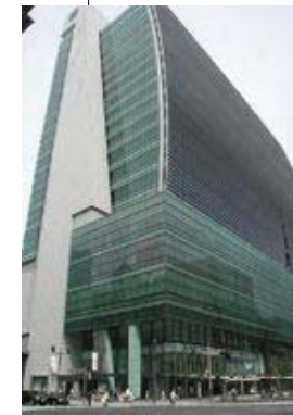
2004 コレド日本橋 (日本橋一丁目三井ビルディング) 規模:A街区・地下4階・地上20階・塔屋1階 B街区(アネックス)・地下2階・地上2階 鋼重:18,850t(5,088t) 旧白木屋呉服店跡地の再開発事業で誕生した複合施設です。 当社は、昭和3年に白木屋呉服店の鉄骨も担当しました。
