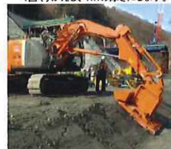
④端部締固機 内部コンクリートの端部を締めます。
