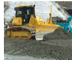
②ブルドーザー 厚さ25cm程度に敷きならします。4回くりかえし、1mの厚さにします。
