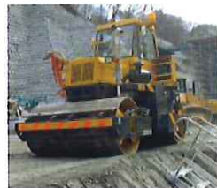
③振動ローラー 鉄輪ローラーを振動させながら締めます。
