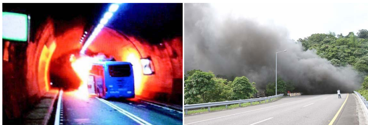
図3 雪山隧道火災車道内および北側出口坑口 3)
