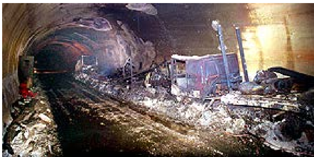
図2 モンブラントンネル火災（対面通行、11800m） 2)
