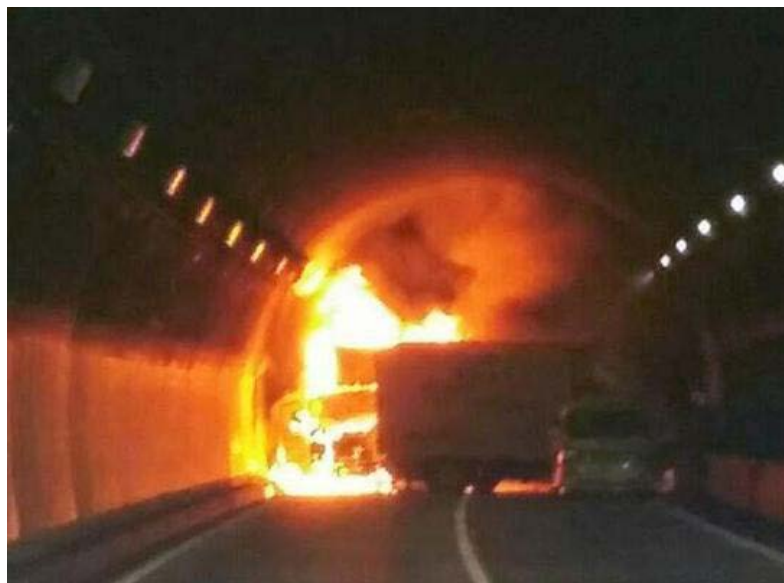
図4 2016年3月17日 山陽自動車道 八本松トンネル（844M）火災事故 4)
