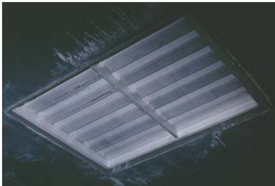
図12 スイスゴットハルトトンネル大排煙口（耐熱温度400℃以上、ステンレス製） 14)
