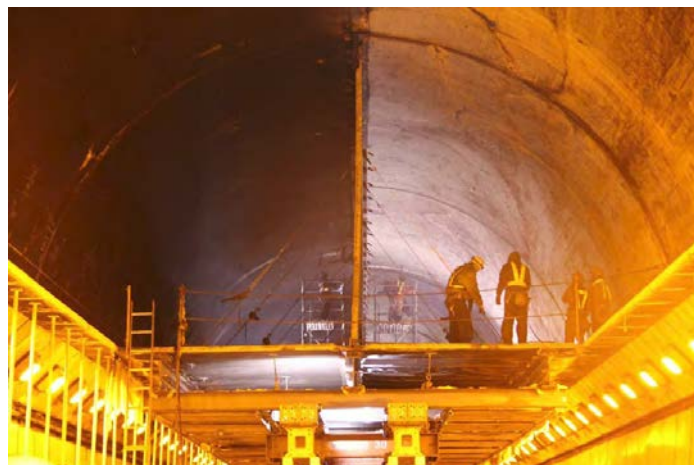
図7 笹子トンネル天井版崩落事故直後の構造点検 9)
