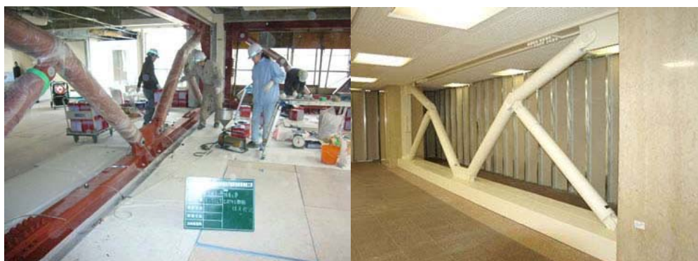
トグル制震構法 施工状況・完了写真(仙台市役所)
