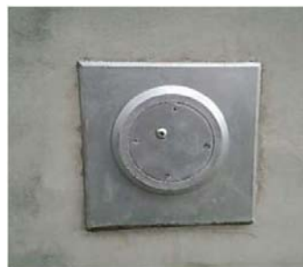
埋込式定着キャップ設置状況
