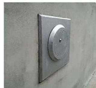
埋込式定着キャップ設置状況
