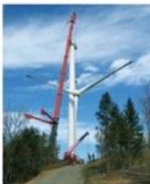
風車組立状況
