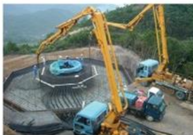
風車基礎施工状況
