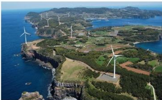
当社施工発電所（長崎県） 当社請負：実施設計、許認可業務、土木建築工事施工
