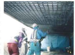
ポリマーセメントモルタル吹付け工法(下面増厚補強)
