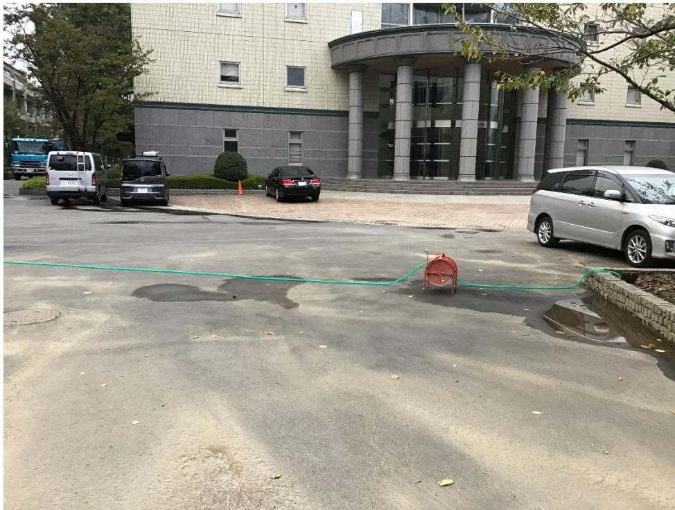
2号館水引後サイドでへドロ除去中
