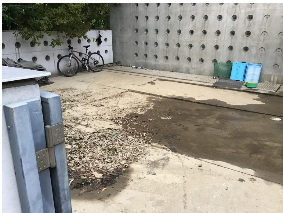
図書館裏水引き後前面はヘドロ除去作業中
