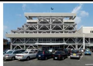
市庁舎本館南面（補修後）
