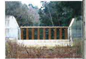
宇治川第二砂防堰堤流木対策工(神戸市)
