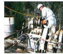
ボーリング調査
