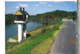
前田川樋管(福島県)
