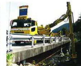
点検車による橋梁点検
