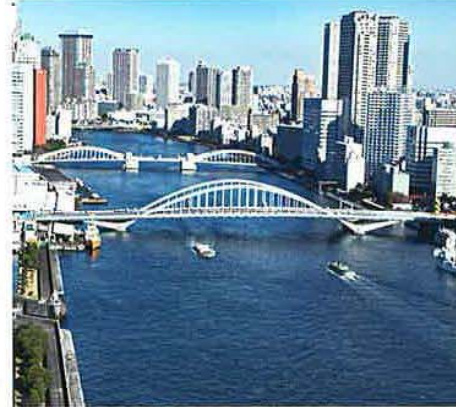
築地大橋(東京都中央区) 施工中
