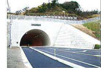
椎谷トンネル(新潟県)
