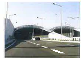
羽田空港北トンネル(東京都大田区)
