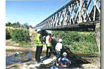
橋梁維持管理能力向上プロジェクト(ザンビア)
