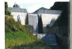
大日向砂防堰堤(長野県)
