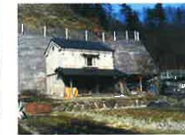
下神井急傾斜地対策工(栃木県)
