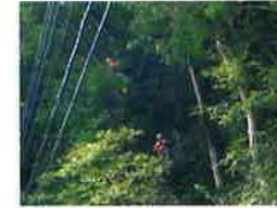
岩盤斜面調査
