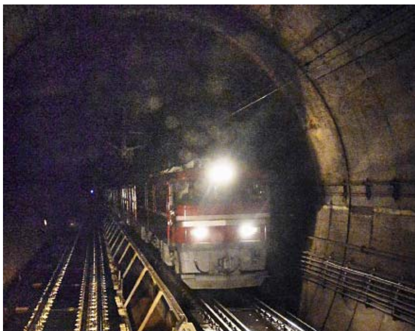
図 22 青函トンネル内部(3線軌条方式) 12)
