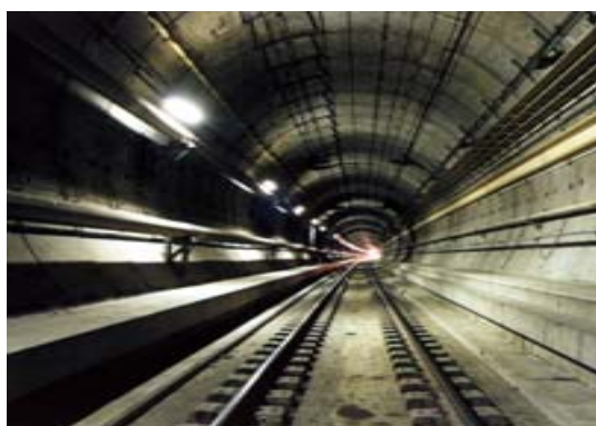
図10 トンネル内部
