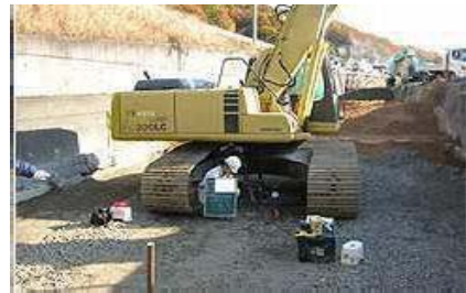
地盤改良工事
