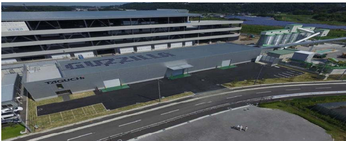
タグチ工業関東工場新築工事
