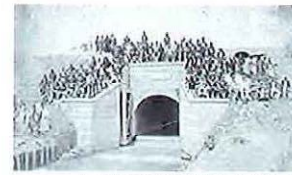
大前門樋(埼玉県古見町) / 昭和4年6月竣工
