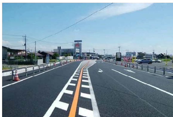
ラグビーロード整備(街路)工事
