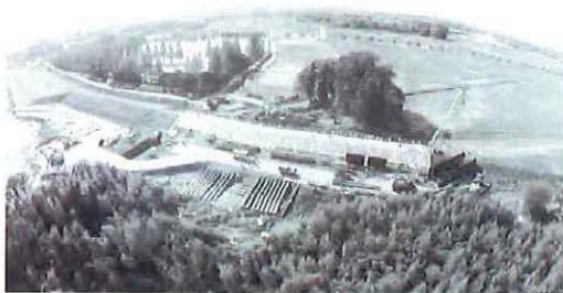
都幾川堤防緊急復旧現場
