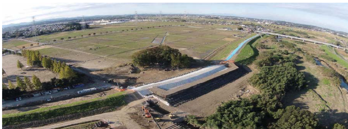
台風19号堤防決壊 都幾川堤防緊急復旧工事
