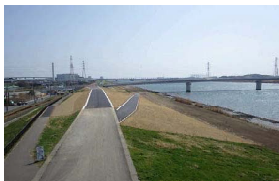
H29高谷地区高潮堤防工事
