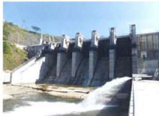
アッパーコトマレ 水力発電所 (スリランカ) スリランカの安定的な電力 供給を目的とした水力発電 所。貯水量約800,000m 3 の重力式コンクリートダム、 長さ13kmの湧水路トンネル、 長さ13kmの湧水路トンネル、 最大出力150,000kWの地 下発電所などを施工した。
