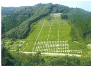
山須原発電所調整池内 崩壊斜面災害復旧 (宮崎県 東臼杵郡美郷町) 平成17年の台風14号が もたらした記録的大雨により 崩壊した。山須原ダム上流 の斜面を復旧する工事。
