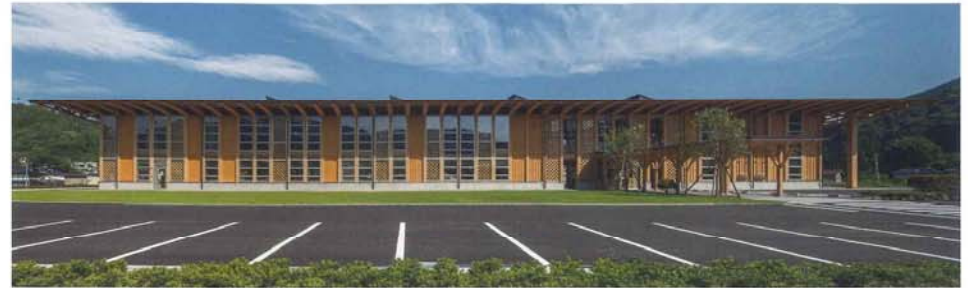
住田町役場(岩手県気仙郡住田町)【第57回DCS賞を受賞】 可産材や地元で製造・加工した木材をふんだんに使用した純木造の庁舎。伝統的な純木造建築のイメージを大切にしながら、先進的なデザインのレンズ型トラス梁やラチス耐力壁を採用した。
