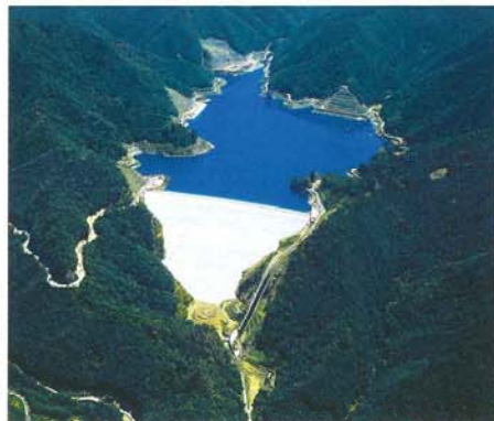
南相木ダム (長野県佐久郡南相木村) 水力発電プロジェクト(2,820,000kW 当時)の上部ダムを構築。堤高139m、 堤頂長444m、堤体積7,300,000m 3 、 総貯水量19,170,000m 3 の中央 土質連水壁型フィルダム。
