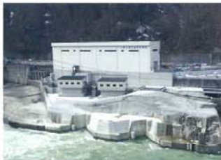
豊実発電所改修 (新潟県 東蒲原郡阿賀町) 昭和2年から昭和4年にか けて、阿賀野川左岸に 施工した水力発電所を、 ダムや魚道などの既設設備 を活かす。機器効率の アップにより最大出力を 56,400kWから61,700kW に上げる大規模改修工事。
