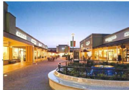
酒々井プレミアム・アウトレット(千葉県酒々井市) プレミアム・アウトレットシリーズ9店舗目となる大型商業施設。約200,000㎡という広大な敷地に、約10店舗のテナントが入る大小15棟の建物と4,700台収容の駐車場を、約10か月という短期間で施工した。
