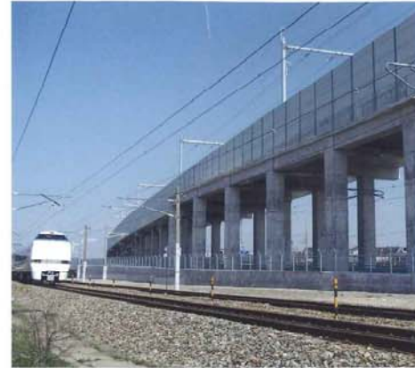
北陸新幹線 白山成町高架橋(石川県白山市)
