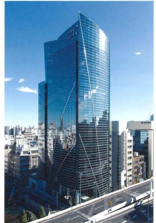
株式会社平和本社ビル(東京都台東区) 当社設計・施工による(株)平和の新社屋ビル。上野周辺のシンボルタワーとなるよう、ダブルスキンカーテンウォールを採用した先駆的デザインとなっている。10階建て、延床面積8,722㎡
