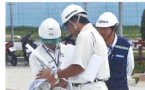
COFICOと当社職員の現場打ち合わせ
