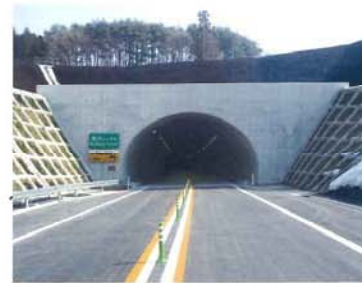
八戸南環状道路 是川トンネル(青森県八戸市)
