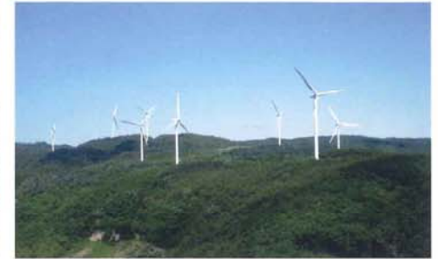
珠洲風力発電所(石川県珠洲市)
