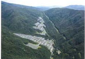
五葉山太陽光発電所
