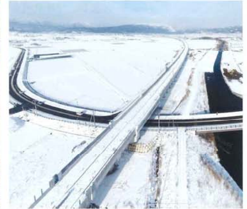
北海道新幹線 飯田高架橋(北海道北斗市)
