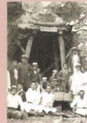
木曾福島発電所工事現場で。 前列中央に座っているのが初代 又兵衛。
