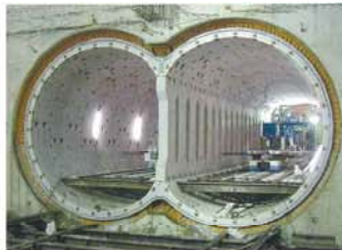
名古屋高速鉄道 (愛知県名古屋市) 高速鉄道4号線の八事 日赤駅から八事駅の駅間 トンネル延長782mを複心 円シールド工法(気泡、DOT 工法)により構築。
