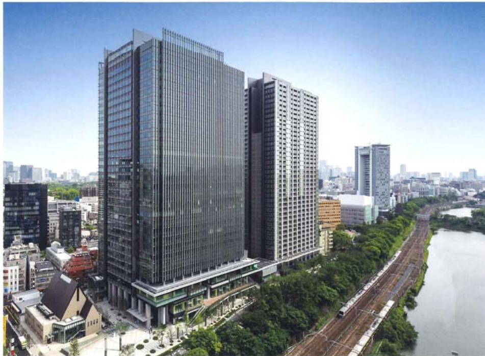
飯田橋駅西口地区第一種市街地再開発事業(東京都千代田区)
