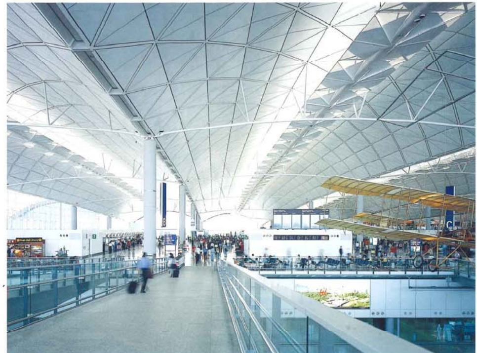
香港国際空港ターミナルビル(香港)
