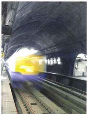
青函トンネル (北海道松前郡福島町) 北海道新幹線、津軽海峡海底下 100m、最大水深140m、トンネル 延長53.85km(海底部23.3km、 陸上部30.55km)のうち吉岡工区 海底トンネルを構築。
