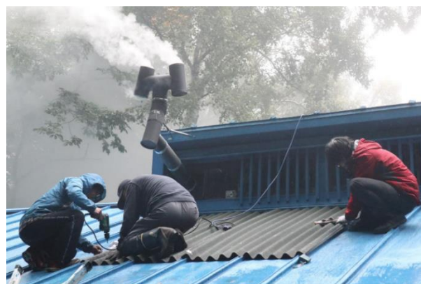
波板の試験施工
