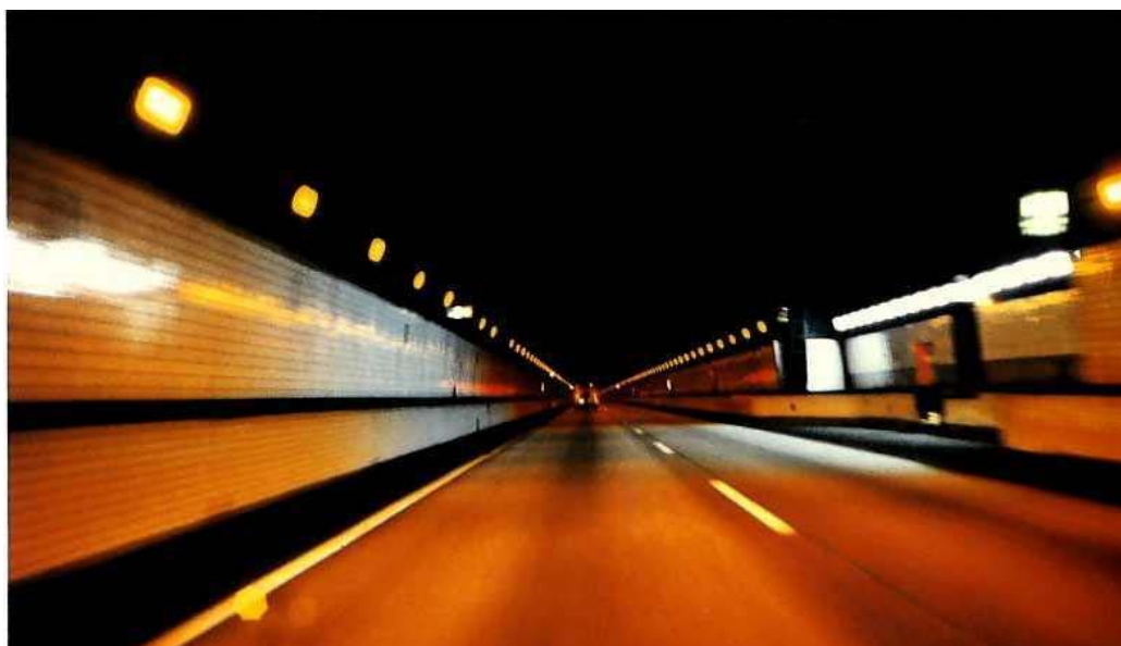
図 24 関越トンネル下り線新潟方面：照明器具 3.5m 12)
