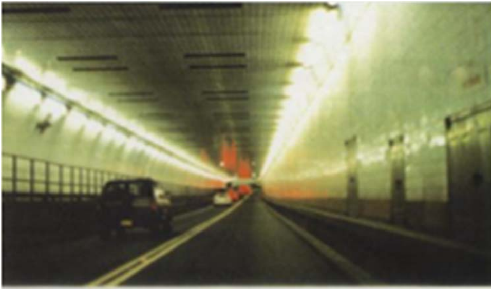
図 29 米国 ニューヨーク、ニュージャージー州間リンカーントネル（都市内トンネル） 12)
