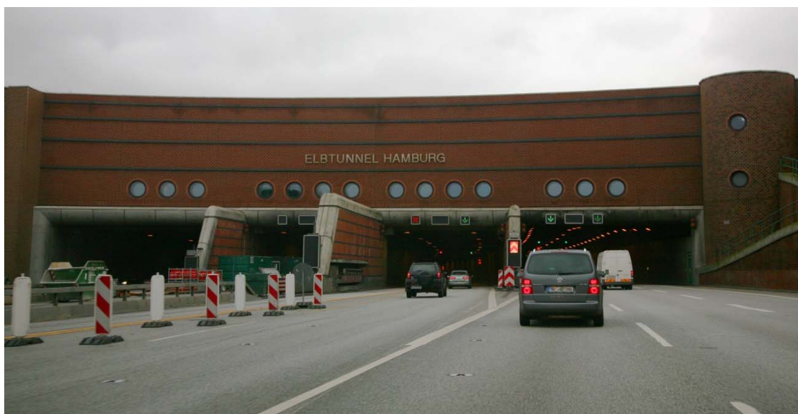
図 11 エルベトンネル南坑口（TBM 陸上トンネル側） 10)
