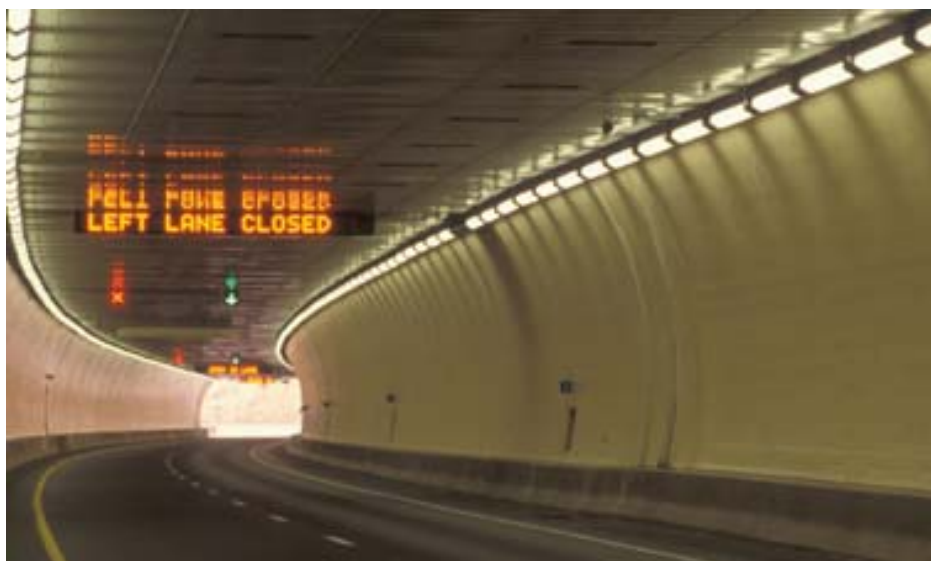
図 28 コロラド州 I-70 号線ハンギングレイクトンネル（都市間トンネル） 15)
