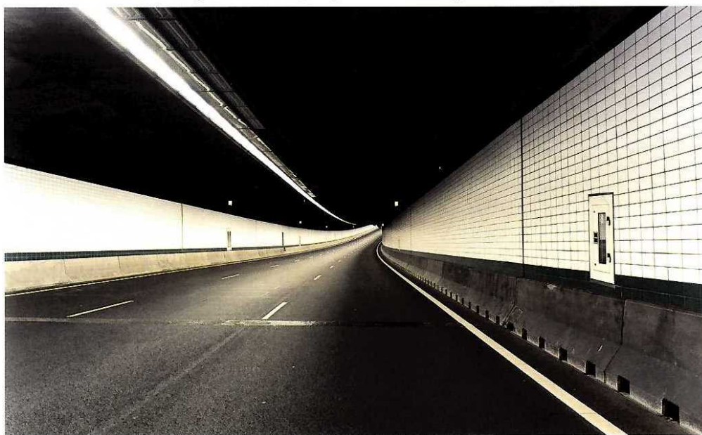
図25 ジーバーガートンネル内部（図8参照） 9)
