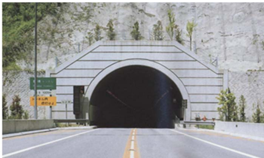
図1 重力式坑口の例：船場トンネル：中国自動車道 1)
