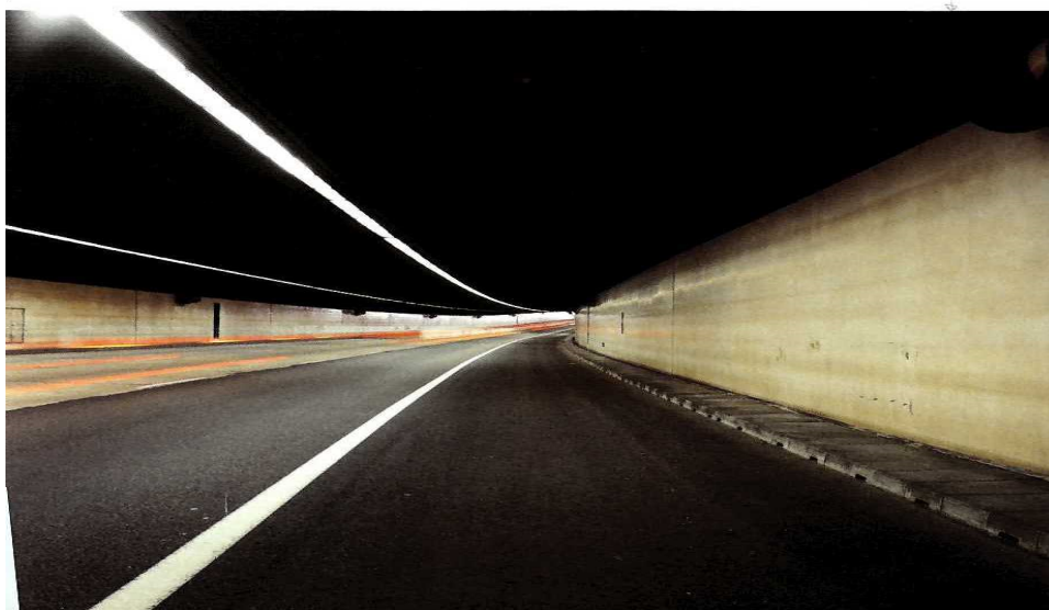
図 26 スキポールトンネル内部（図 9 参照） 9)
