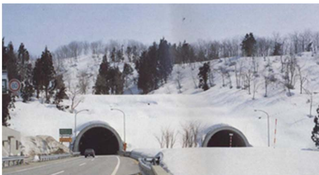
図 2-2 坑口の例（積雪期）：関越自動車道 越後川口トンネル 1)
