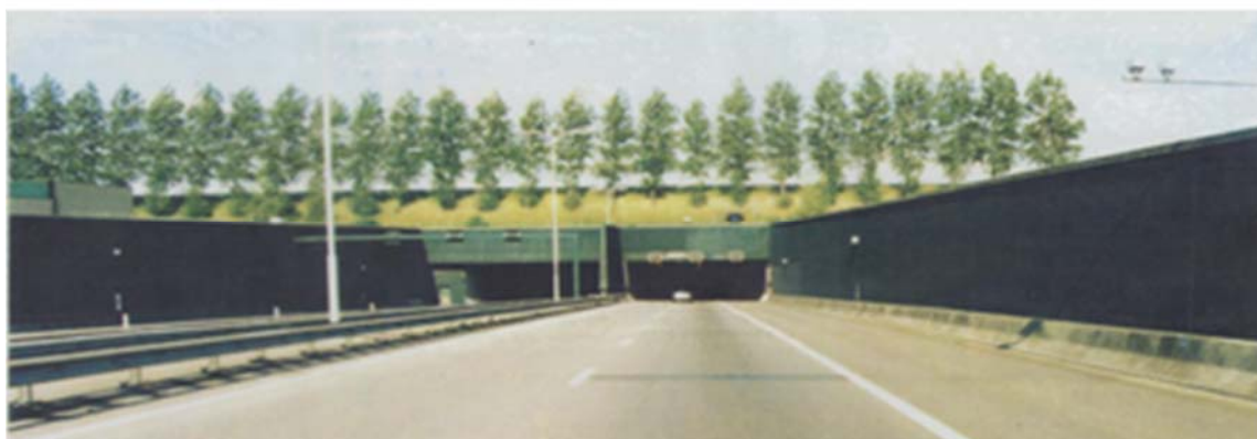
図 10 ヴラーケトンネル南坑口 9)
