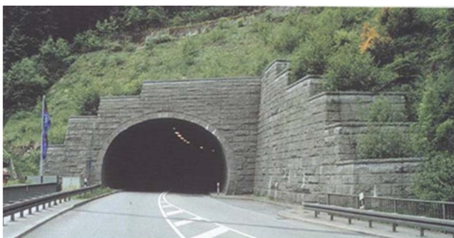
図 15 ズッケルヒュットトンネル 1)
