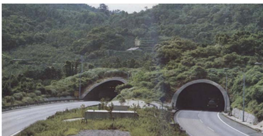
図1 重力式坑口の例：船場トンネル：中国自動車道 1)
