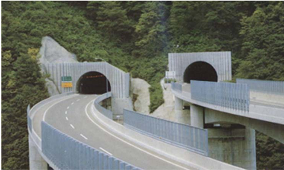
図 17 笹の渡トンネル（東北自動車道） 1)
