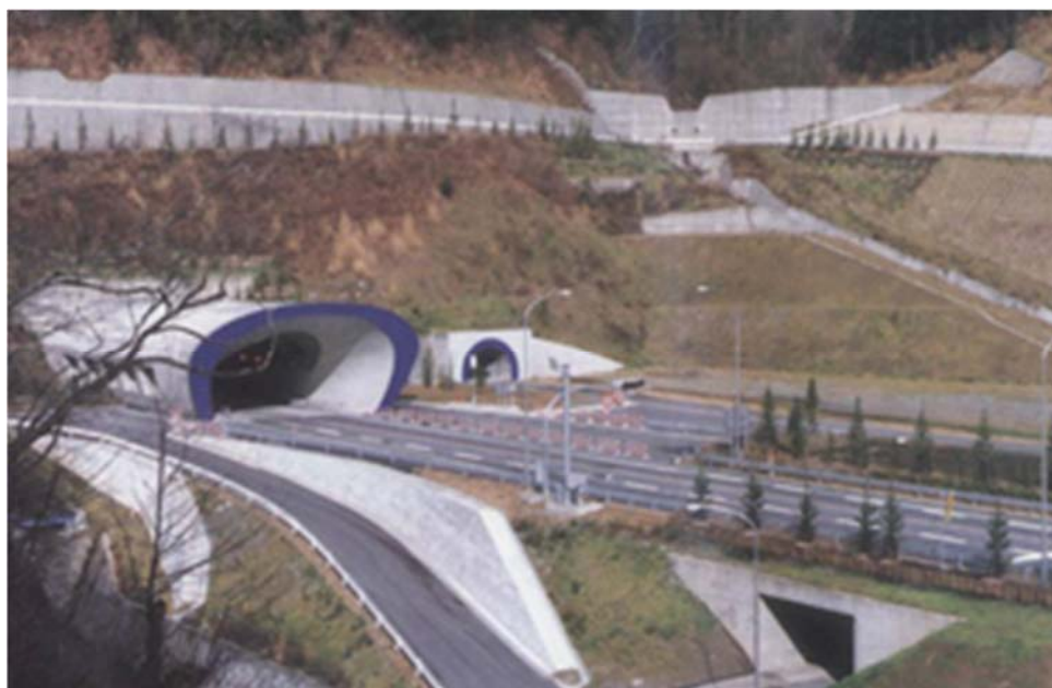
図6 関越トンネル水上側下り線坑口全景 1)
