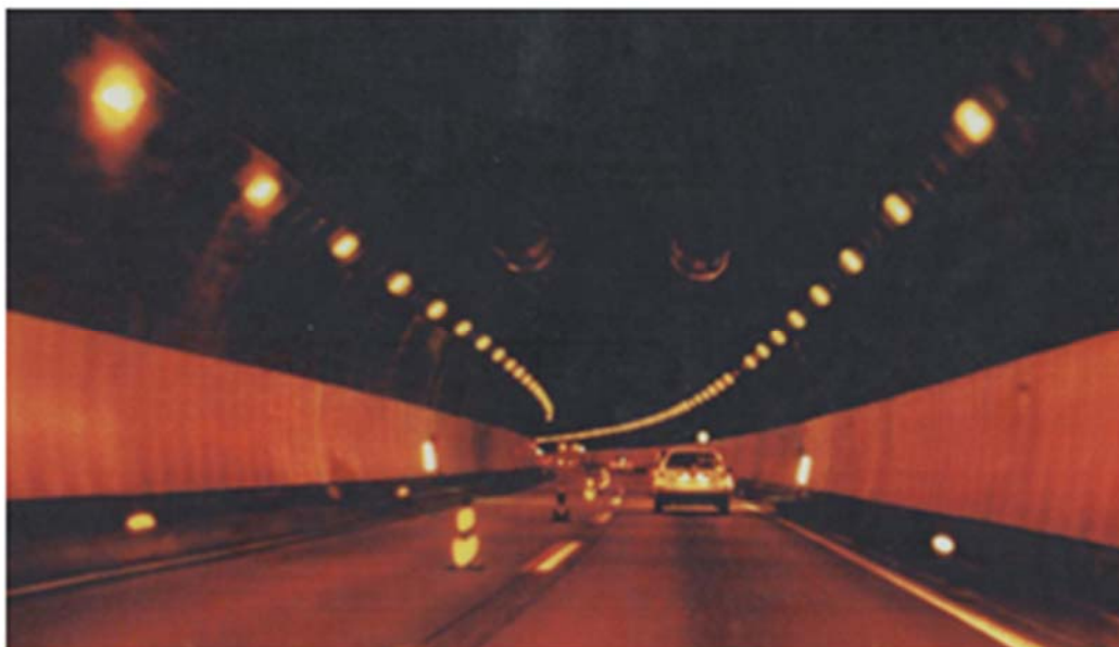
図 23 標準的都市間高速道路トンネル：照明器具 4.5m（東名高速道路） 12)
