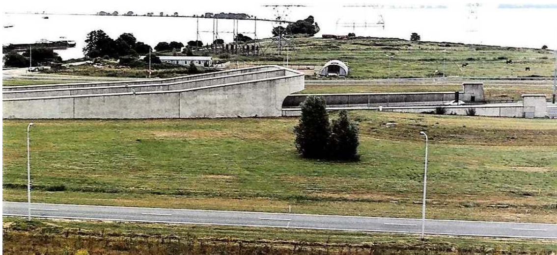
図8 ジーバークートンネル 坑口部 9)
