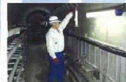
監室操作室監視機状況
