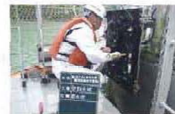
観音水質観測設備点検状況
