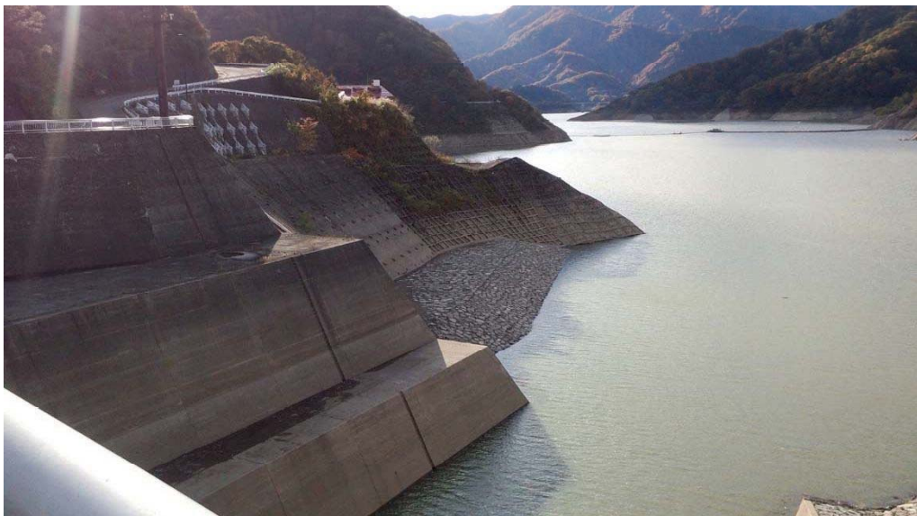
(6) 堤体左岸ダムサイト最近の土留めアンカー
