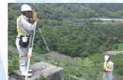
堤体外部実地調査状況
