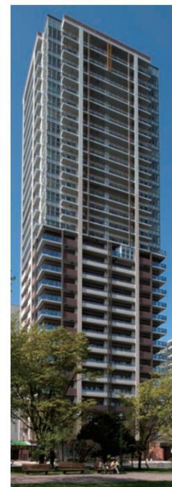
SHRCは、風に揺れにくく建設コストの安い鉄筋コンクリート造の特徴を活かしたRC造超高層住宅システムです。柱・梁の主フレームは在来のRC工法(バルコニーのみPCまたはハーフPC化)でありながら、高強度材料の使用や施工法の合理化により、工期も短縮します。
