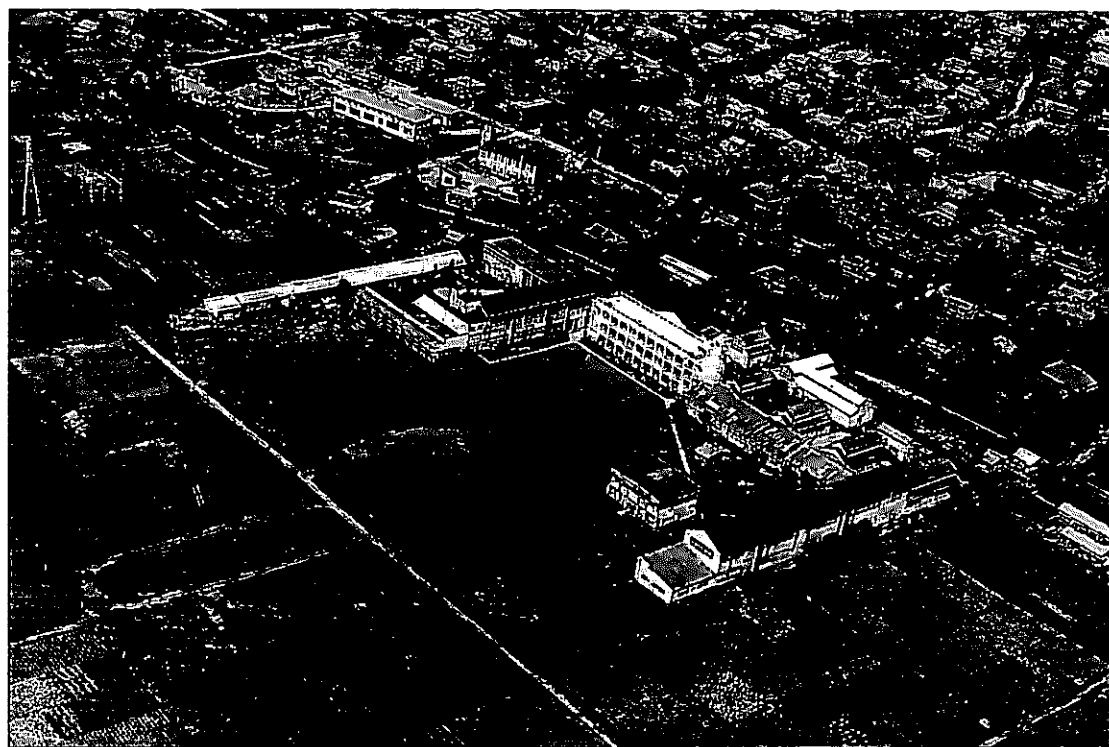
尾山台校舎全景（昭和 32 年当時）
