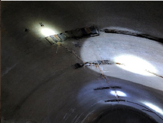
(照明器具取付用木れんがの跡)
