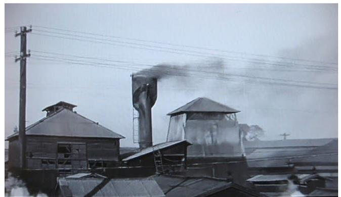
の埼玉県川口市には多く見られます。屋外に見えているのはキューポラに付属する排煙筒（83ページの写真を参照）で、キューポラ本体が屋根から突き出していると炎や燃焼した細かいコークスが飛び散り、周辺の延焼の原因になります。キューポラ以前の甑（こしき）全盛の時代では、工場群の屋根からコークスの炎が立ち上る風景が川口のあちこちで見受けられ、これにちなんでか、川口オートレース場では例年「GI 日刊スポーツキューポラ杯争奪戦」（優勝賞金 300 万円）が行われています。
