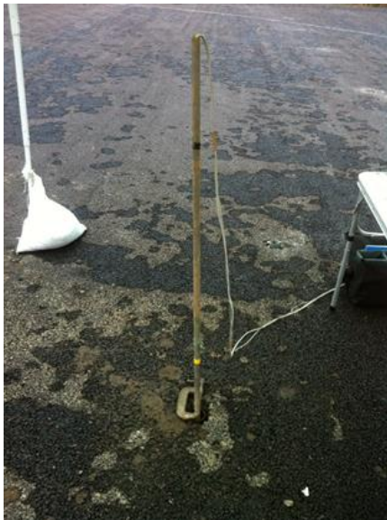
写真-3 伝熱プローブ挿入後の様子
