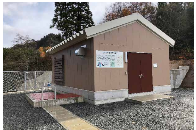
米沢大平小水力発電所
