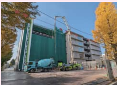
新10号館二期工事の様子
