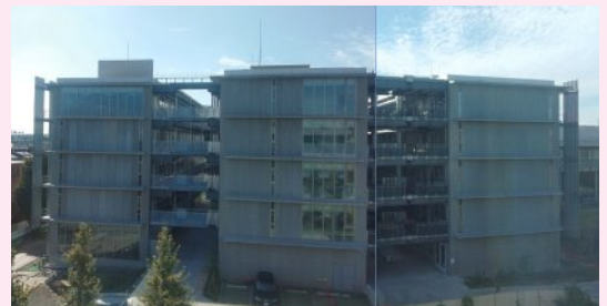
10号館(左が二期工事, 中央と右が一期工事)
