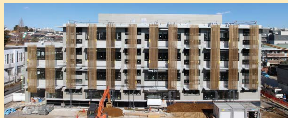
C1棟南側より見る
