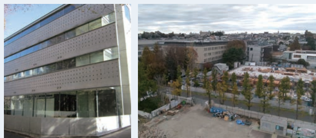
(写真1) 4号館まわりの止水壁
