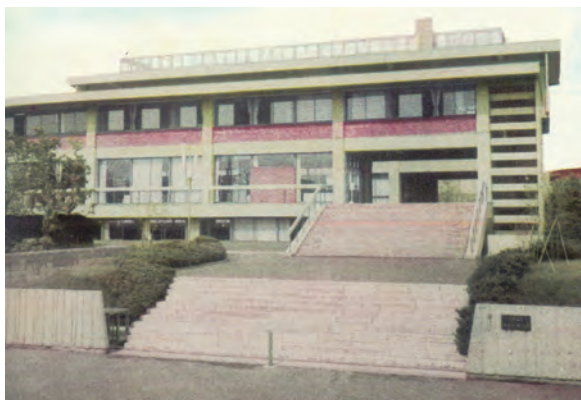
1966（昭和41）年文科校舎竣工
