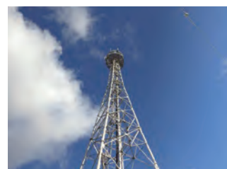
修繕した通信鉄塔
