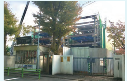
世田谷キャンパスB地区における新棟建設の現場
