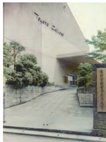
1955（昭和30）年短期大学ならびに講堂竣工
